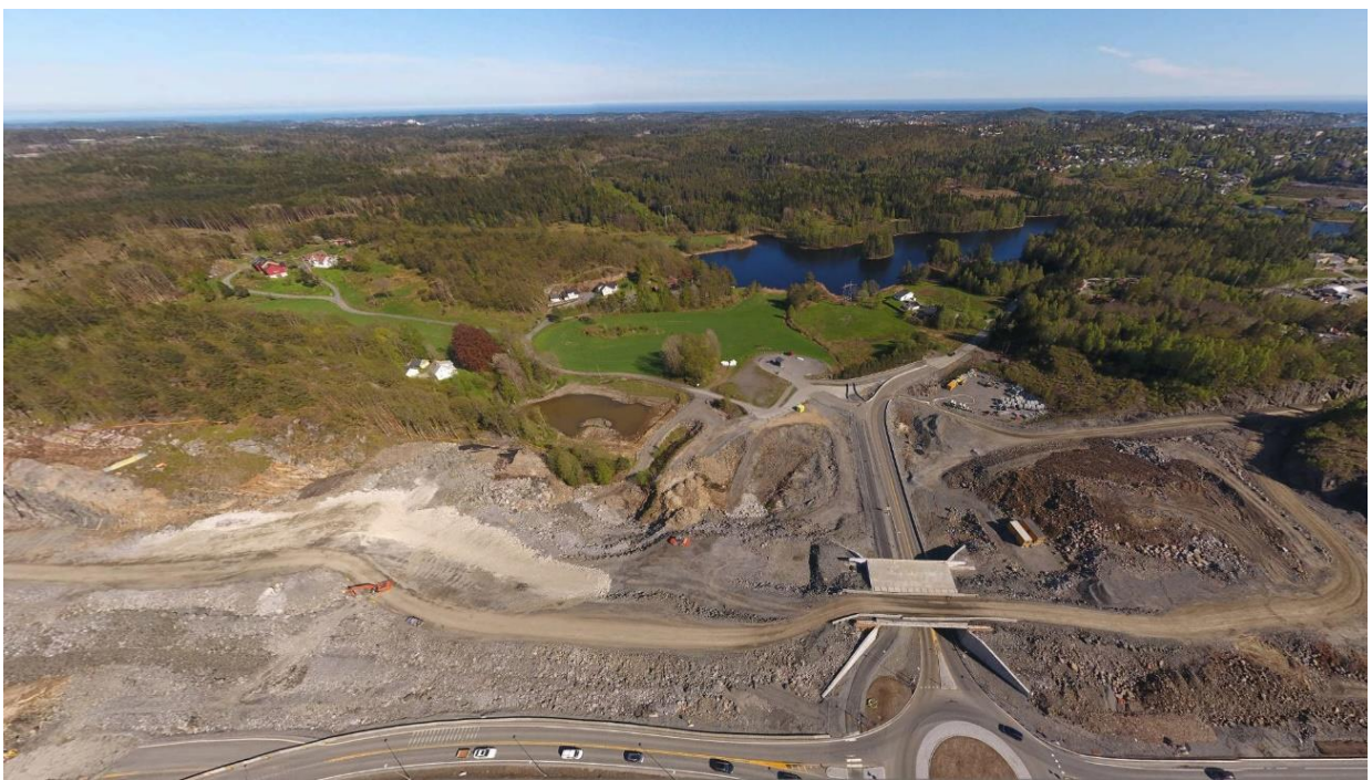
Fig. 1 The Stølen site in E18 Arendal-Tvedestrand May 2018
